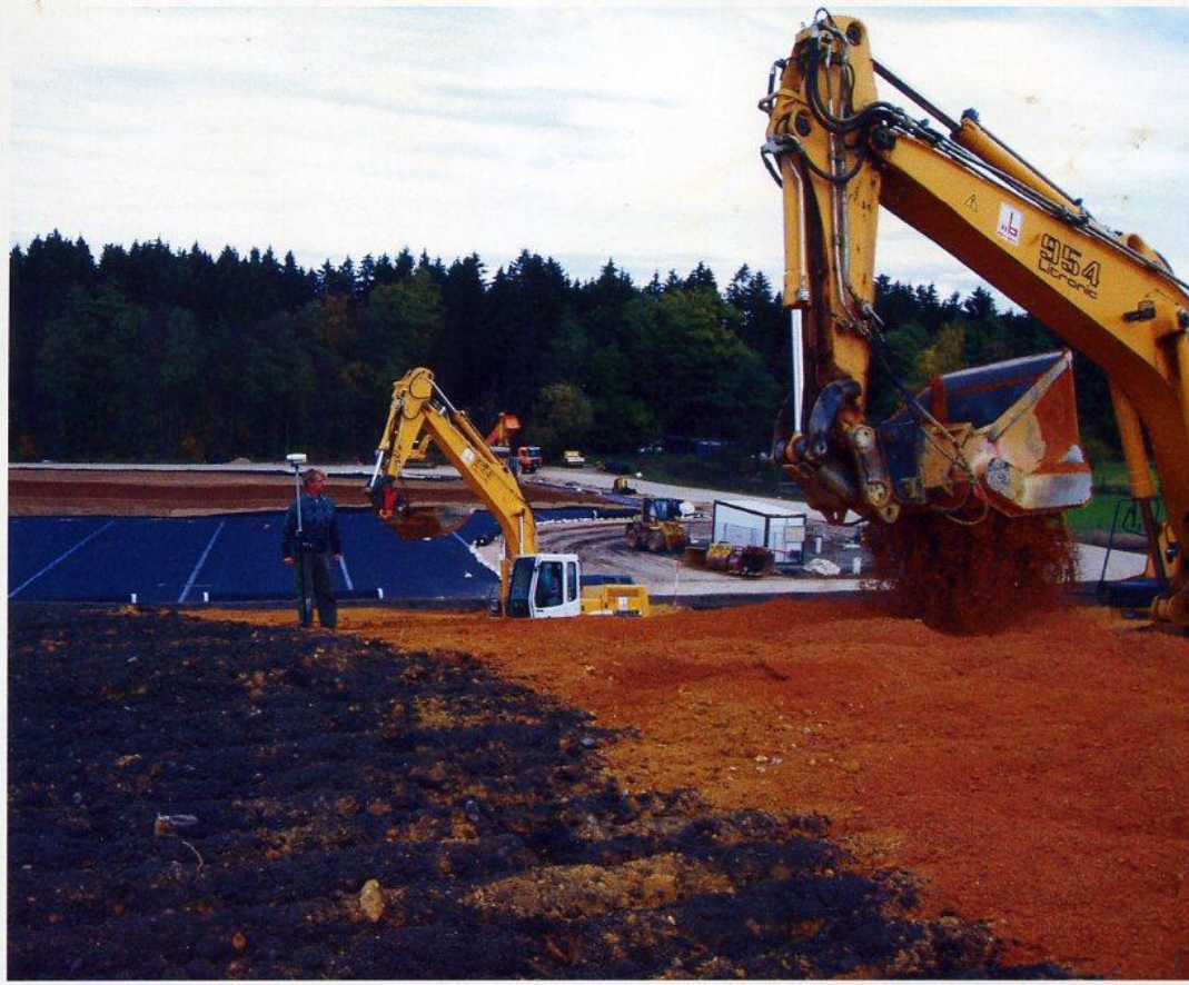
Einbau der Wasserhaushaltsschicht
